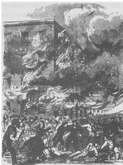
Incendio en la armería de la Segunda avenida
