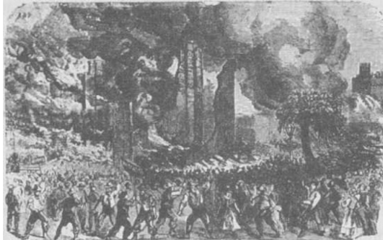
Incendio en las oficinas de la Tercera avenida
